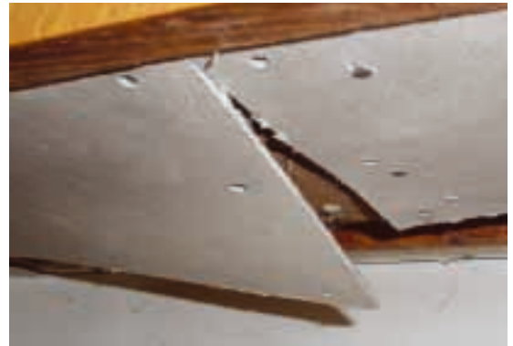
Asbesthaltige Leichtbauplatten
